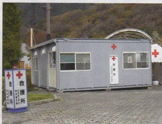
東日本大震災でも活用したユニットハウスの救護所
